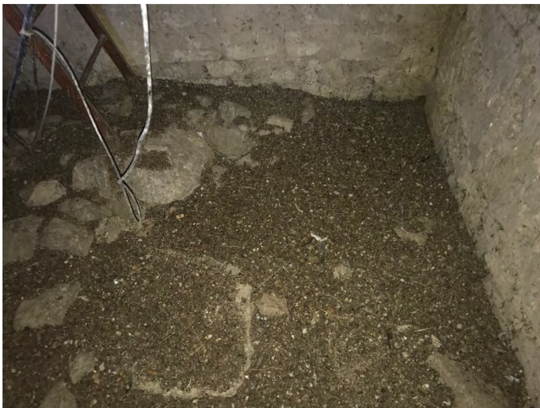
Estradosso del primo orizzontamento con la “sporizia” lasciata dal tempo e soprattutto dai piccioni
