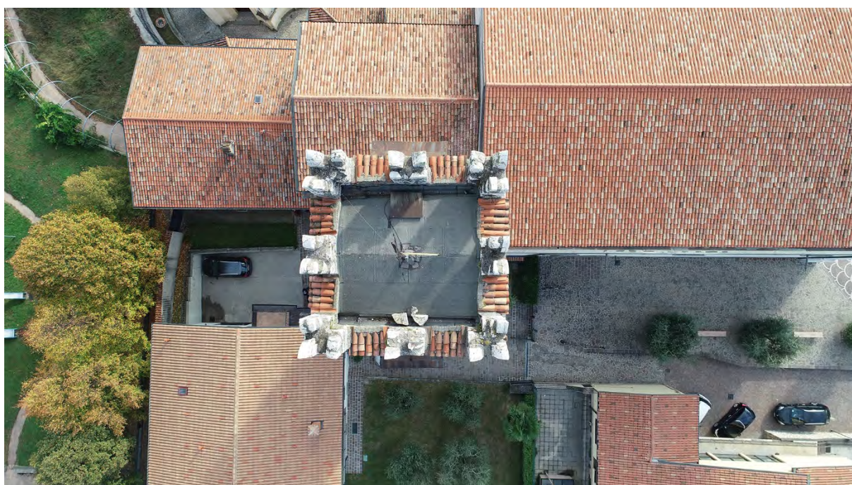
Vista zenitale della copertura della torre campanaria
