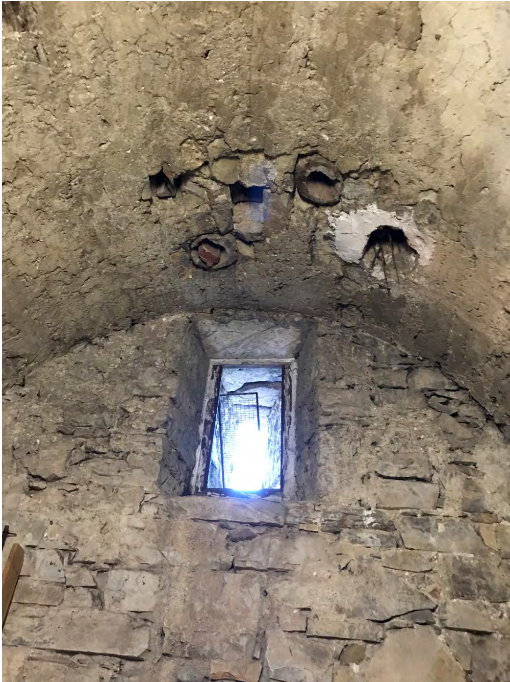
Intradosso del primo orizzontamento
